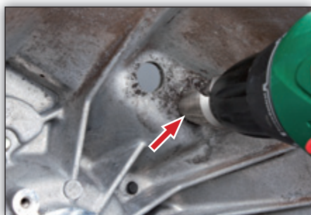
Fig. 5: Alargamento dos orifícios com uma broca.
